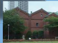
旧醸造試験所第一工場
