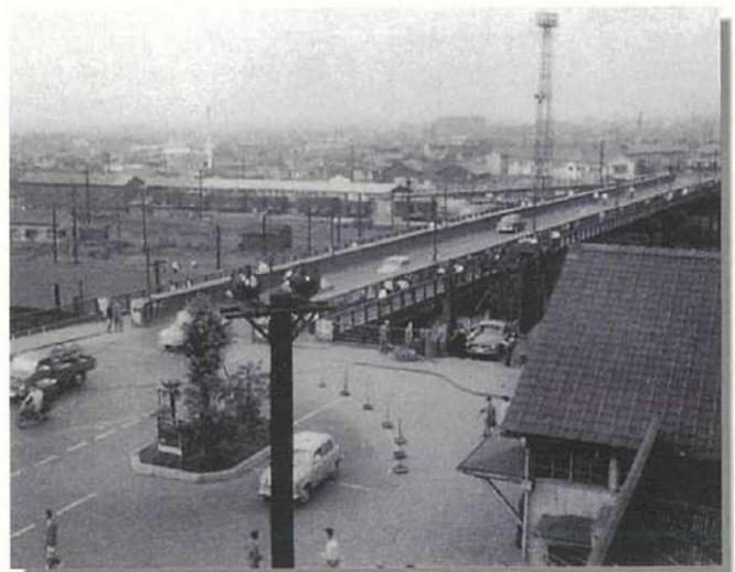
田端大橋 現在の田端ふれあい橋 (昭和37年頃) 交通量の増加に伴い、昭和62年にこの田端大橋の隣に新田端大橋が架けられました。田端大橋が、田端ふれあい橋として歩行者専用橋にリニューアルされたのは平成4年のことです。 (倉田正義氏提供)
