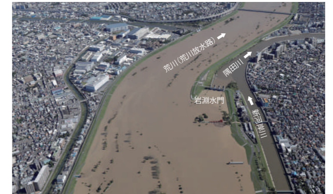
東京都北区岩淵水門付近（2019年10月13日13時頃撮影）
