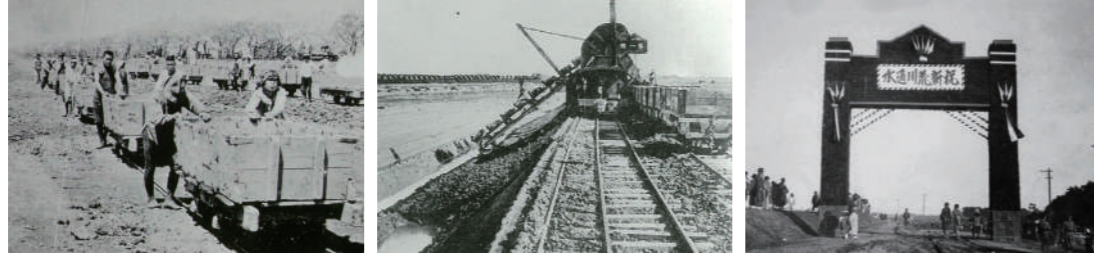
人力掘削の様子
