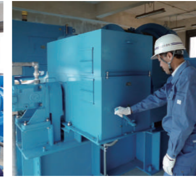
自重降下装置による操作状況
