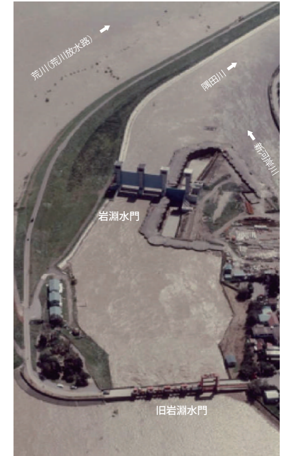
岩淵水門建設中の様子（第2期工事）：1982年（昭和57）9月台風（水門工事期間中においても、隅田川に流水分派させる水路）を確保するため、半川締切で2期に分けて施工しました。
